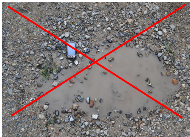
Abbildung 6: Eine gut instandgehaltene Baustellenstraße darf keine Schlaglöcher aufweisen, die tiefer als 30 mm sind und/oder eine Verteilung/Anhäufung von Schlaglöchern, die nach vernünftigem Ermessen des Auftragnehmers ungeeignete oder unsichere Fahrbedingungen zur Folge haben.
