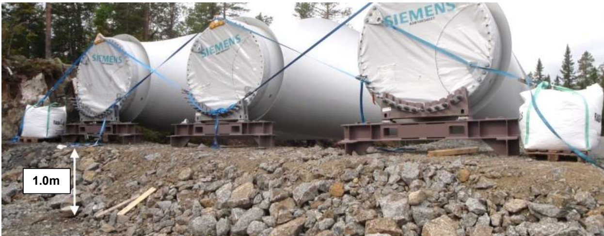
Abbildung 16: Beispiel eines Endes des Bereich für Stützböcke der Rotorblätter q4 .
