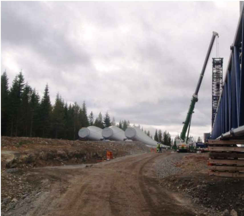
Abbildung 14: Beispiel für eine befestigte Stellfläche q2 auf hügeligem Gelände. Ungeachtet des Gefälles der angrenzenden Straße, muss q2 in jedem Fall geebnet sein.
