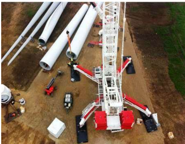
Abbildung 12: Beispiel der Anordnung des Kran und der zu lagernden WEA-Komponenten auf einer dreieckigen befestigten Stellfläche mit Rotormontage.
