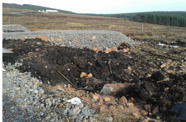
Abbildung 27: Beispiel für einen inakzeptablen/unvorbereiteten Arbeitsbereich
