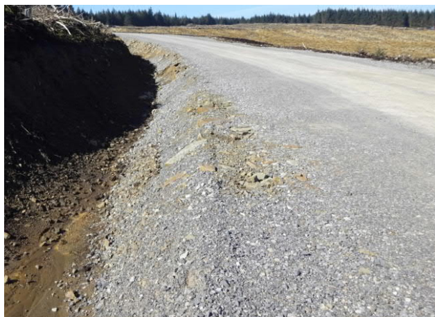
Abbildung 7: Beispiel für eine gut gepflegte Schotterstraße mit einem Gefälle für die richtige Entwässerung.
