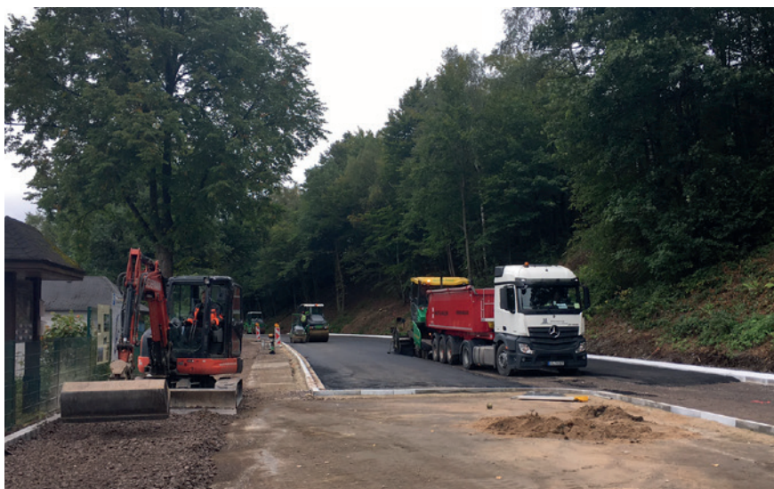
Umbau der K 5 in Hückeswagen schafft Platz für Fußgänger und Radfahrer (Foto: OBK)
