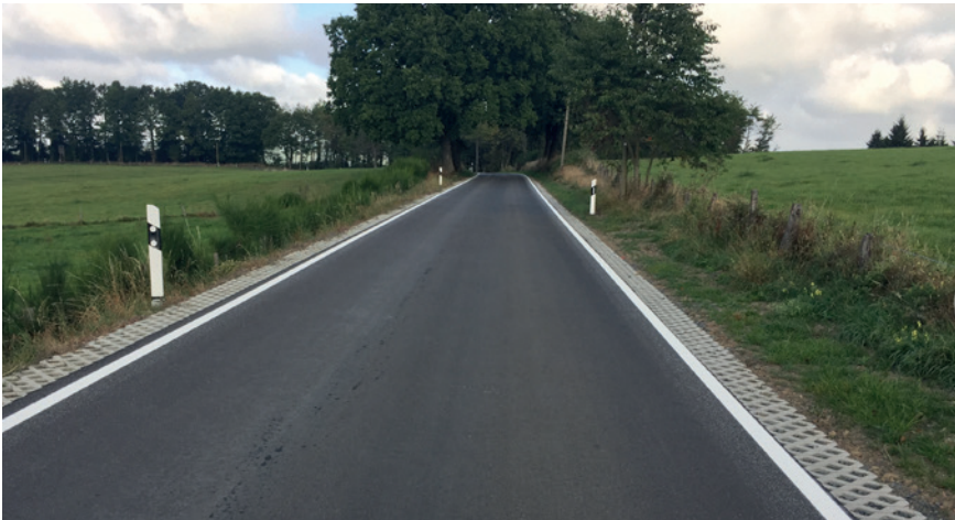
Überfahrbare Rasengittersteine verbreitern die Fahrbahn bei Begegnung großer Kraftfahrzeuge für Begegnungsfälle (Foto: OBK)
