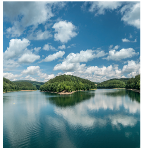
Blick auf die Aggertalsperre (Foto: Dominik Ketz)
