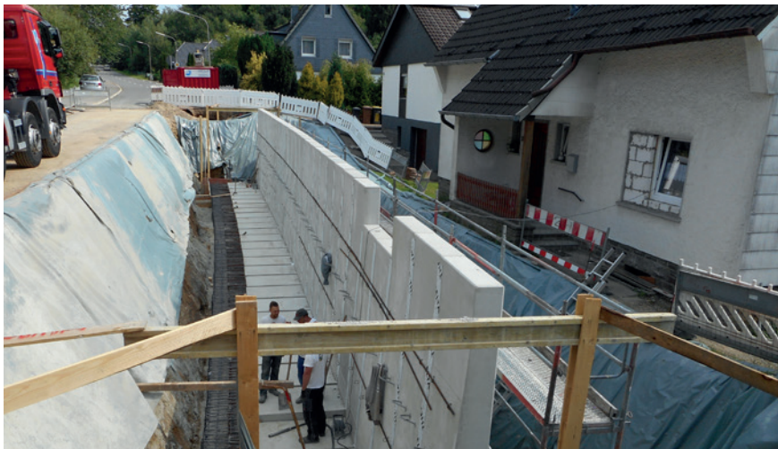
Erneuerung einer großen Stützwand an der K 21 in Lindlar (Foto: OBK)
