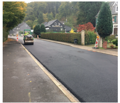
Deckenerneuerung auf der K 58 in Hückeswagen (Foto: OBK)
