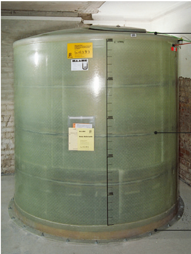
Abbildung 12: Auftriebsicherung bei standortgefertigtem GFK-Öltank
