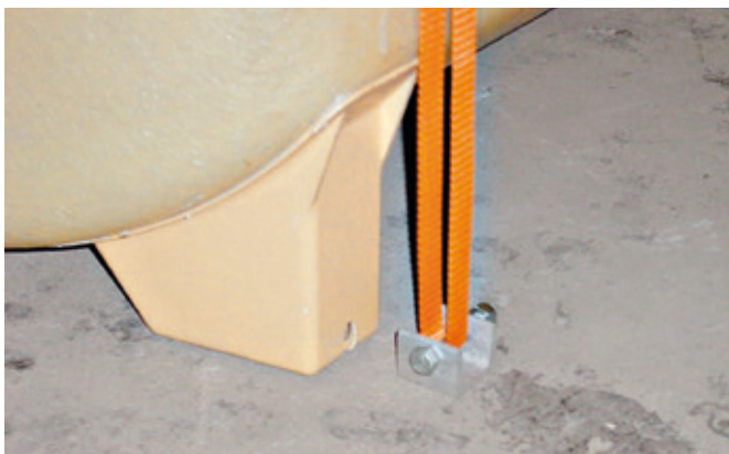
Abbildung 18: Hochwassersichere Aufstellung (Bsp. Fa. CEMO)
