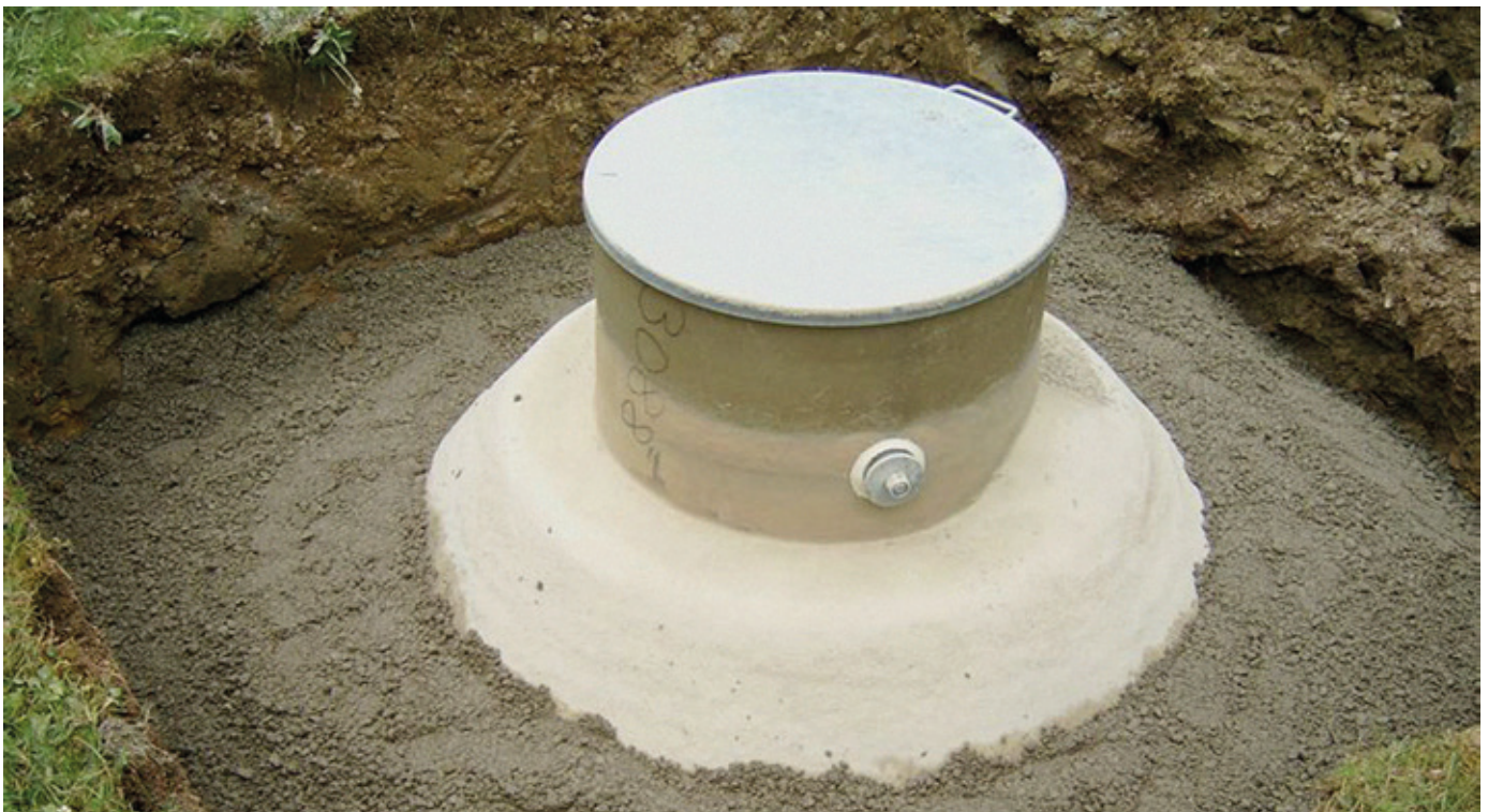
Abbildung 4: Auftriebsicherung unterirdischer Öltank (GFK-Tank)
