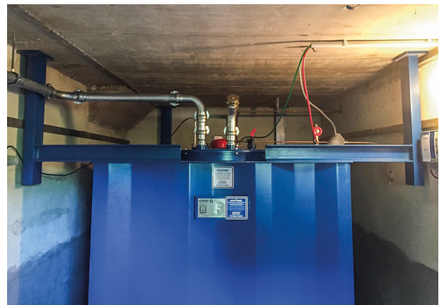
Auftriebssicherung standortgefertigter Stahltank
